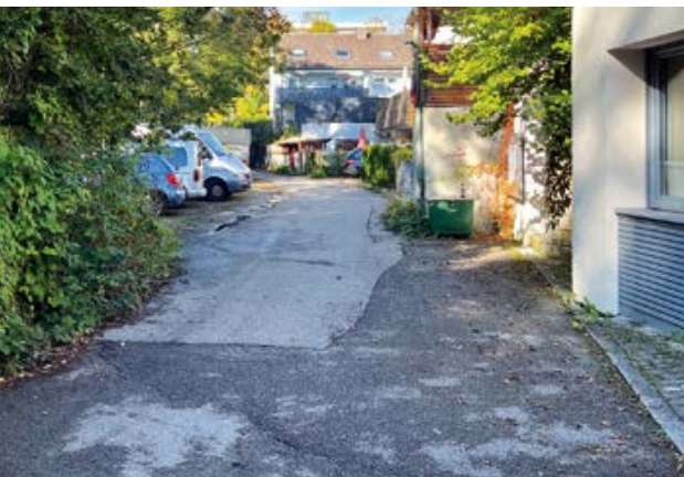
Der südliche Abschnitt der Straße An der Würmleiten wird ab dem Frühjahr 2025 saniert
