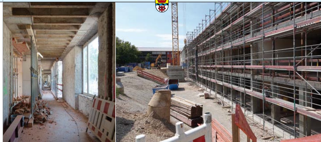
Links: Sanierung im Inneren des Nordtrakts. Rechts: Blick in den Werkhof auf der Südseite
