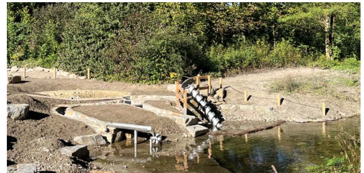
Der Wasserspielplatz kurz vor der Fertigstellung
