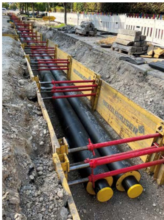
Rohrleitungsbau für das Fernwärmenetz in der Bahnhofstraße
