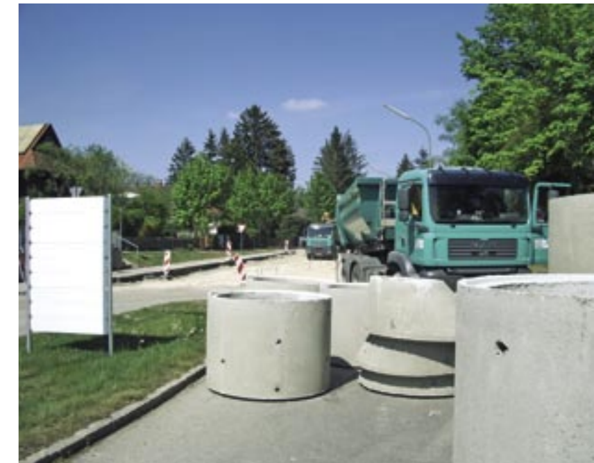
Friedenstraße während der Sanierung
