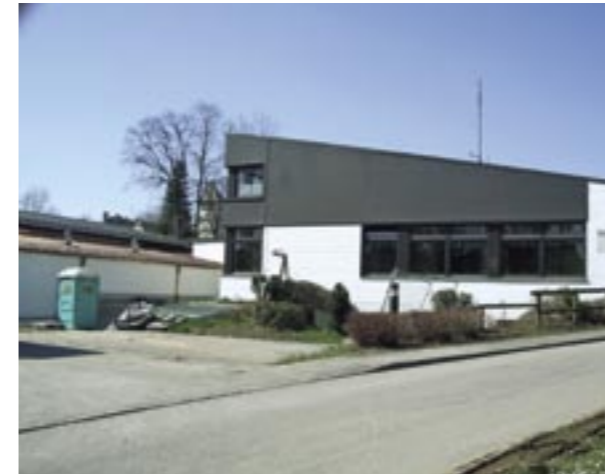
Bauarbeiten an der Freiwilligen Feuerwehr
