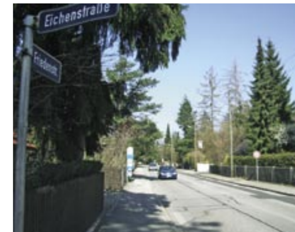
Friedenstraße vor der geplanten Sanierung
