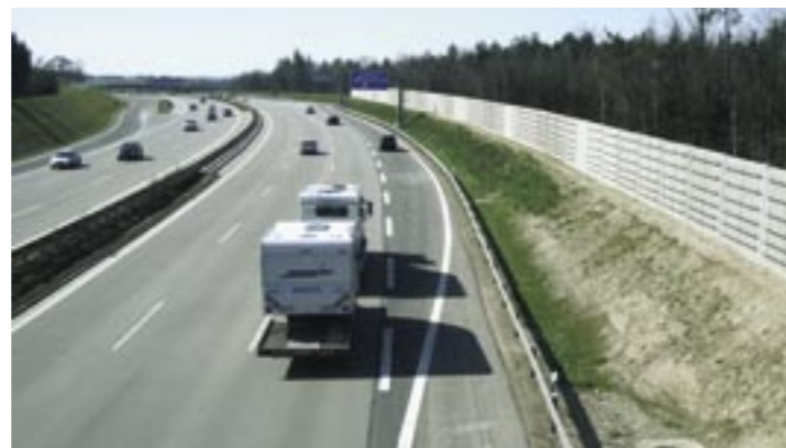
Lärmschutzwall an der A 96
