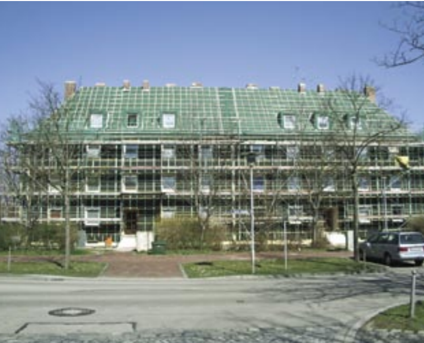
Sanierungsmaßnahmen am Gebäude in der Bahnhofstraße
